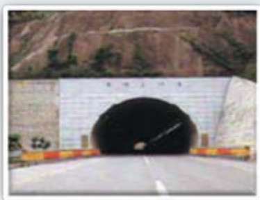
Hầm Chonduk số 2 Đường quốc lộ 22
