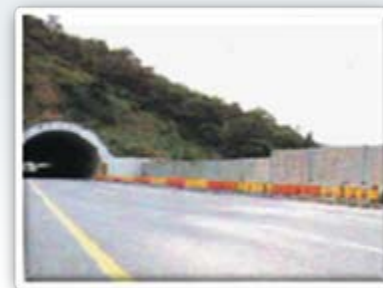
Hầm Chonduk số 1 Đường quốc lộ 22
